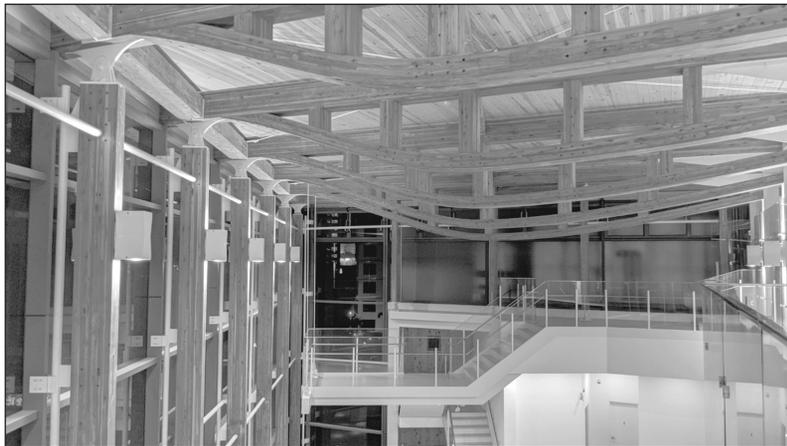
圖 11 B 棟大廳完工後之木構造集成材樑柱系統（照片提供：黃明威建築師事務所 / 王銘顯建築師事務所）
