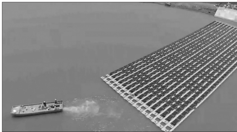
圖 3 浮筒水上拖曳作業示意圖
