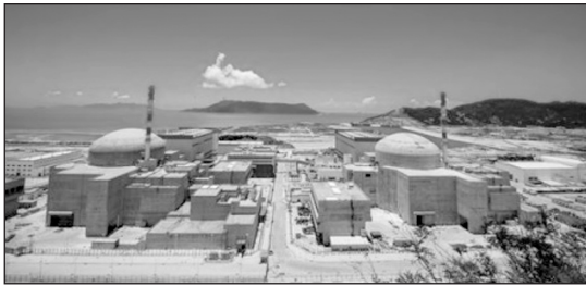
圖4 台山核電廠一號機與二號機，廣東省江門市台山市赤溪鎮，EPR 2 x 1660 MWe
