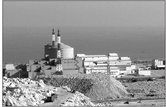
圖六 興建中的田灣核電廠的一號及二號機組（VVER-1000, 1050MW），江蘇連雲港。
