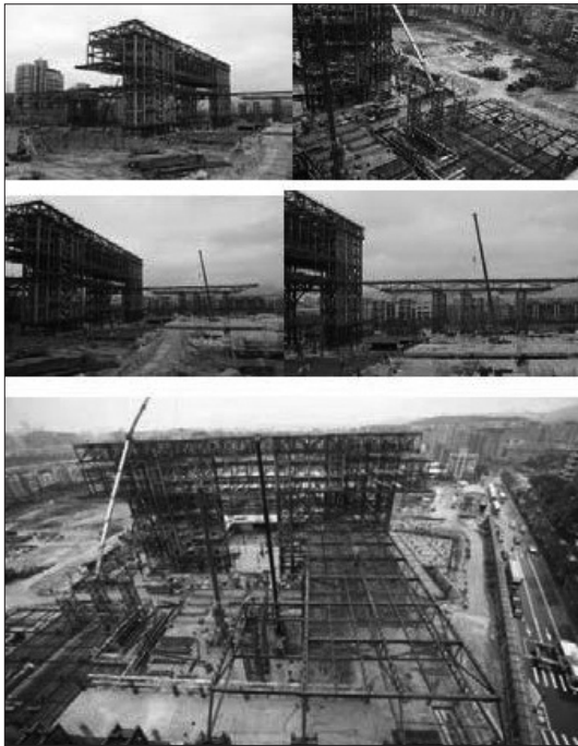
圖 8 屋頂桁架吊裝照片輯
