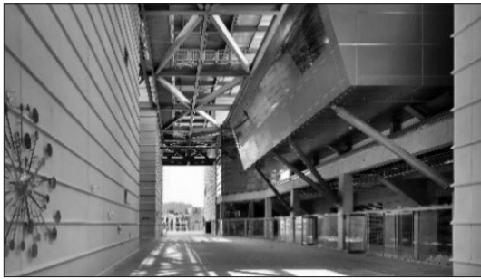
圖 2-7 中央塔樓入口通廊
