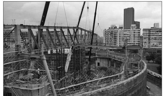
圖 11 籃球館鋼構桁架吊裝過程
