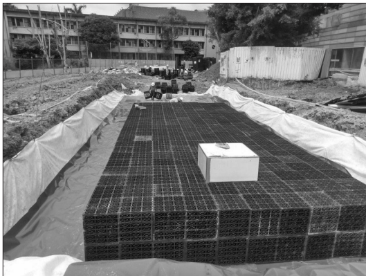
圖 9 水撲滿施工過程
