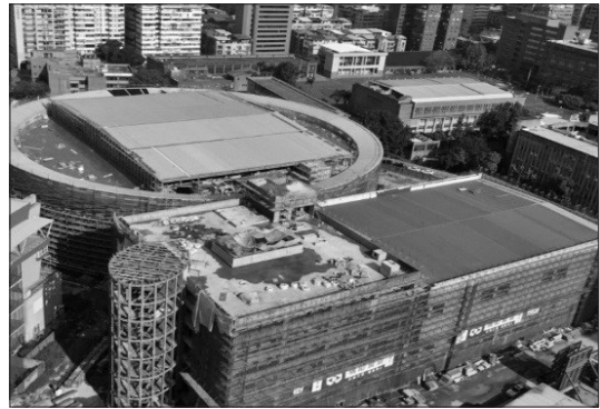
圖 12 鈦鋅版屋頂施工過程
