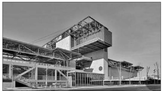
圖 2-13 鋼構懸吊系統 (一)
