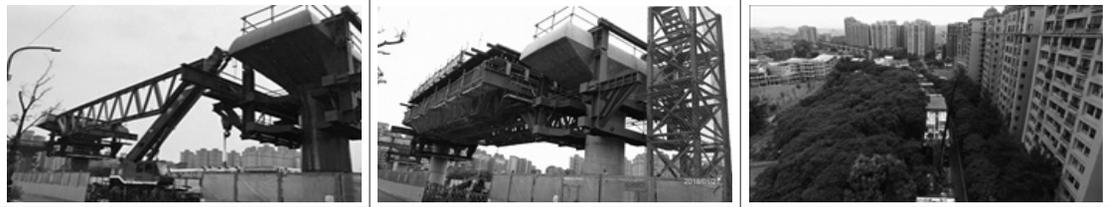
圖 30 船型桁架場撐工法施工實況
