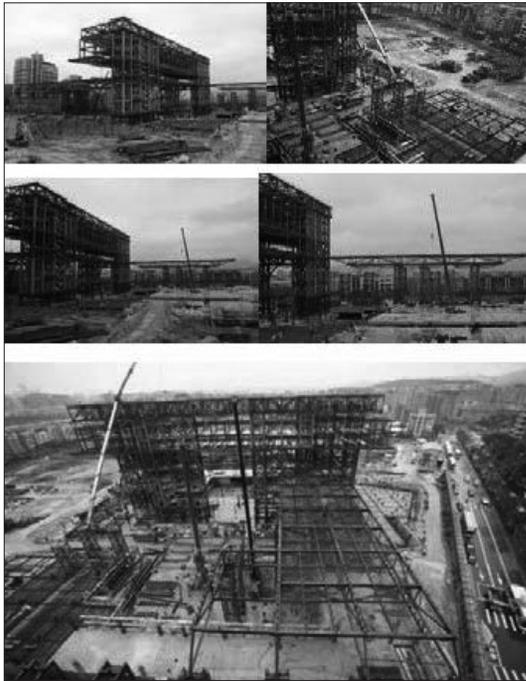
圖 8 屋頂桁架吊裝照片輯
