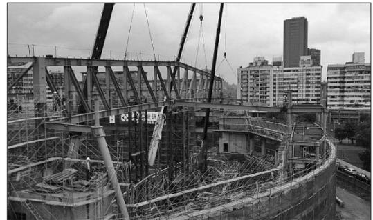
圖 11 籃球館鋼構桁架吊裝過程
