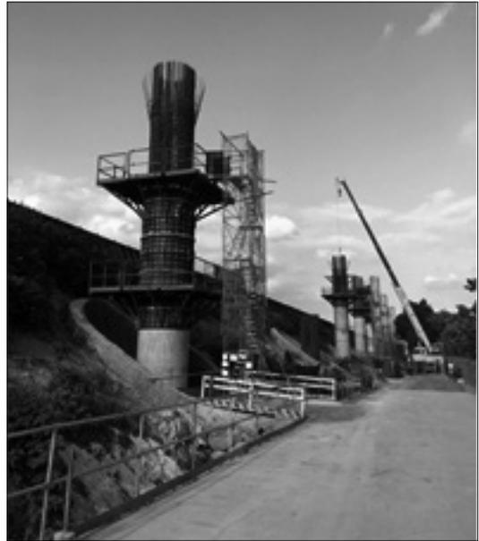
圖 24 墩柱鋼筋綁紮輕量碟型工作平台
