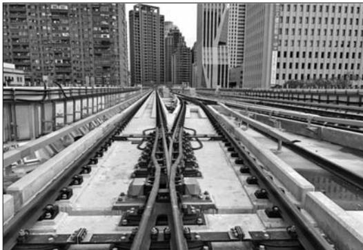
圖 10 可動式岔心 (Swing Nose Crossing)
