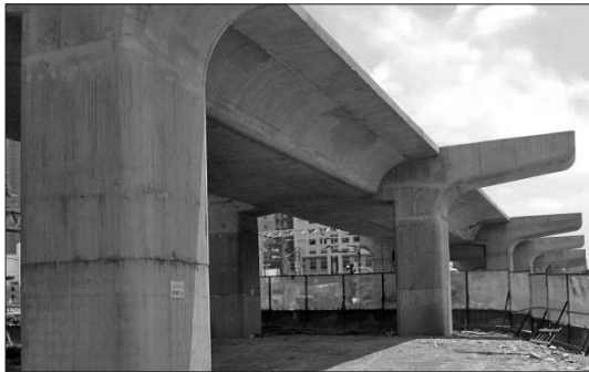
照片 1 岸壁式車站區橋梁先行施築
