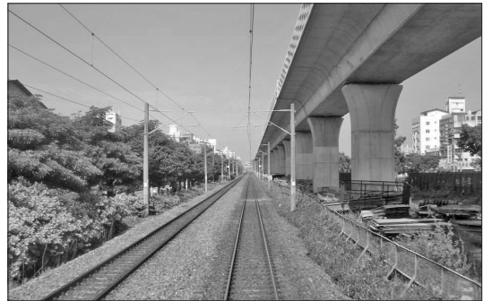
照片3 臺中計畫橋梁
