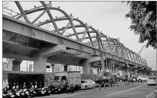
照片 2 月台及雨棚接續構築
