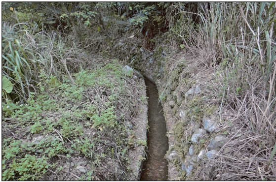
二圳改善段施工前 (111.09)
