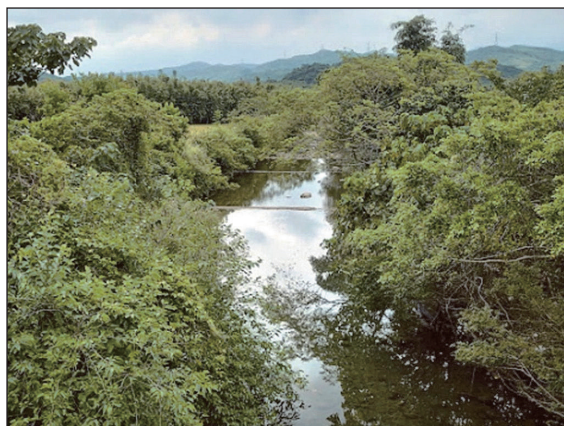
固床工 1 ~ 3 施工前（111.07）
