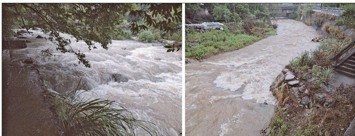
圖 38 山陀兒颱風後的全斷面魚道（左）及階梯下方的丁壩（右）
