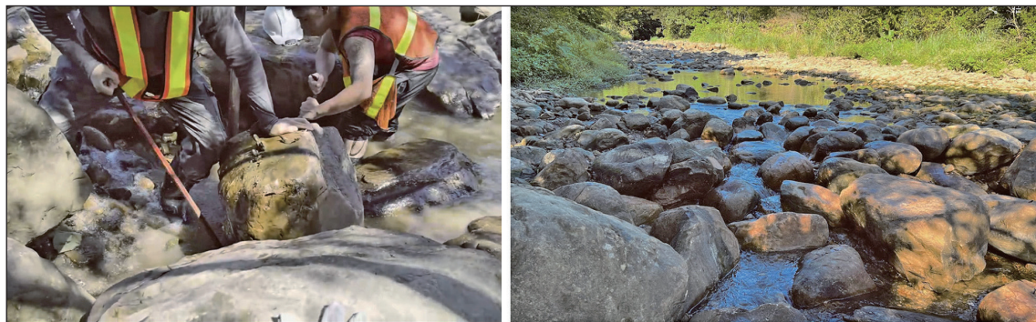
圖 23 調整石梁工塊石，創造早期生物通道（113.07）
