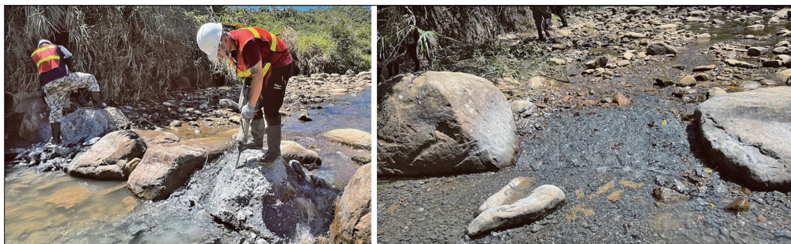
圖 24 固床工 9 落差打除，營造緩坡（113.07）
