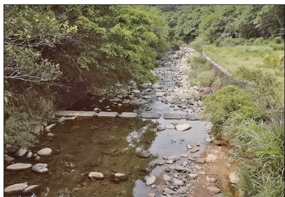
固床工 11 施工前 (110.07)
