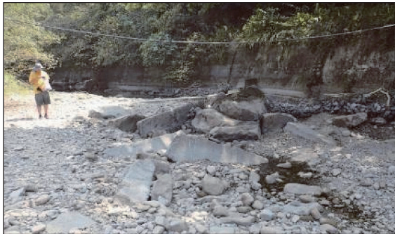
固床工 4 施工前
