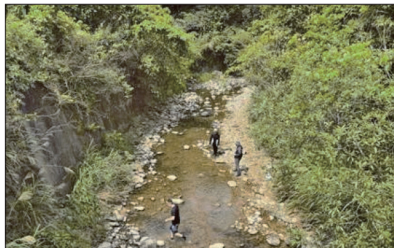
一號橋下游完工後 (113.04)
