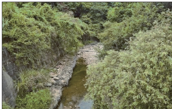
一號橋下游施工前 (111.07)
