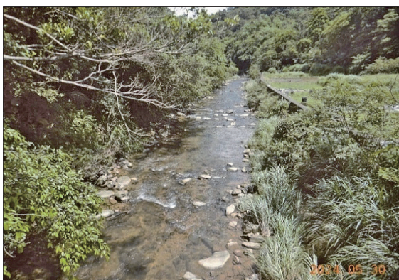
固床工 11 完工後 (113.05)
