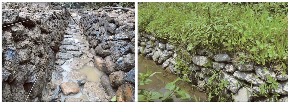
圖 16 二圳改善段施工中（左）及完工後（右）
