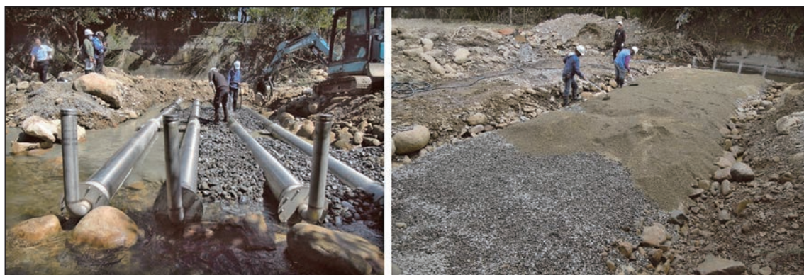
圖 13 繞線式不銹鋼集水管及濾層鋪設情形
