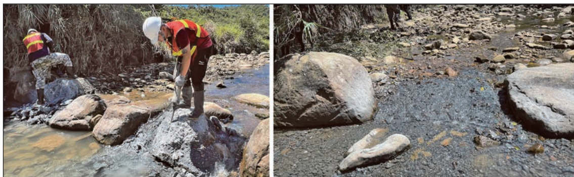
圖 24 固床工 9 落差打除，營造緩坡（113.07）
