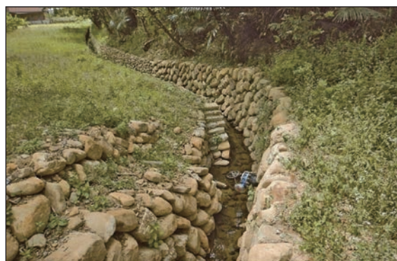
二圳改善段完工後 (112.07)
