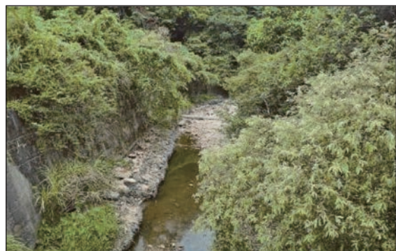
一號橋下游施工前 (111.07)
