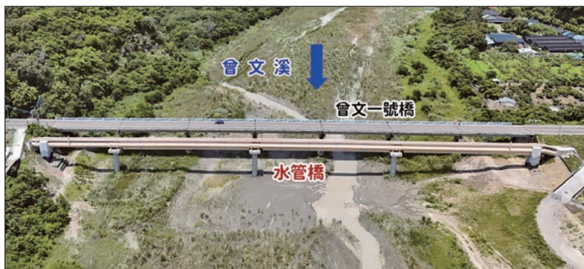
圖 16 完工後之水管橋
