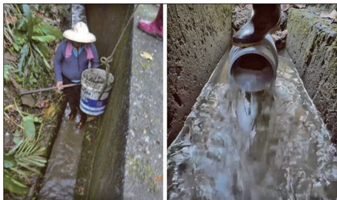
圖 37 過往三圳清淤情形（左）及伏流水供水現況（右）
