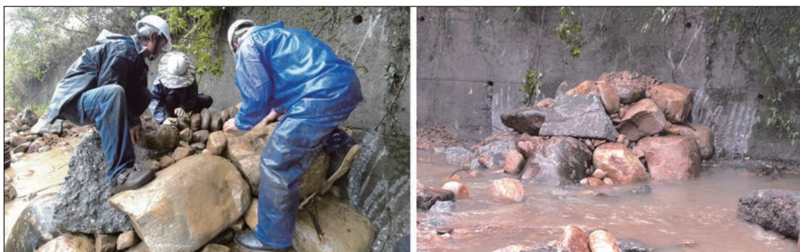
圖 19 固床工局部改造成砌石丁壩施工中（左）及完工後（右）
