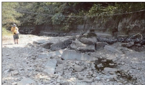
固床工 4 施工前
