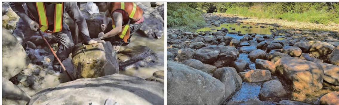
圖 23 調整石梁工塊石，創造早期生物通道（113.07）
