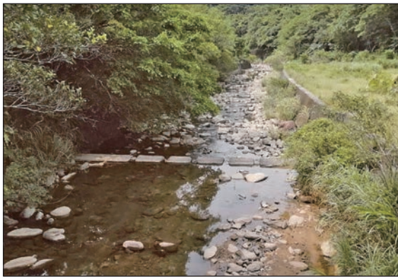
固床工 11 施工前 (110.07)
