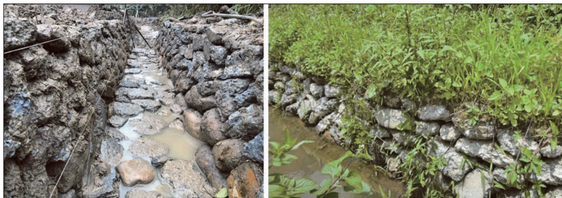
圖 16 二圳改善段施工中（左）及完工後（右）
