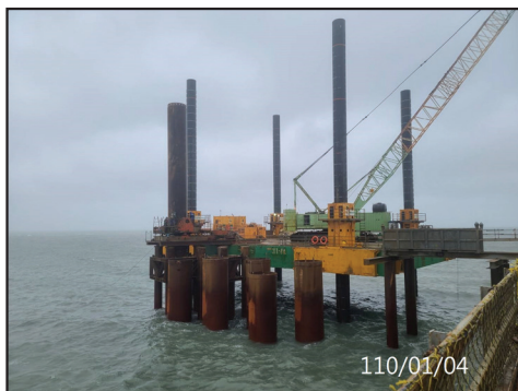
圖 16 本工程外套鋼管及全套管基樁施工照片
