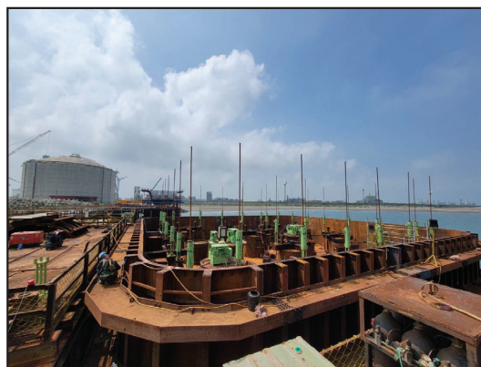
圖 18 本工程樁帽圍堰施工照片
