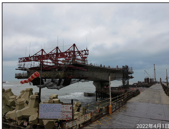
圖 20 本案懸臂工法施工照片
