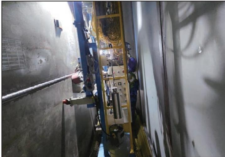
圖 8 儲槽夾層特製自動化潛弧銲接機
