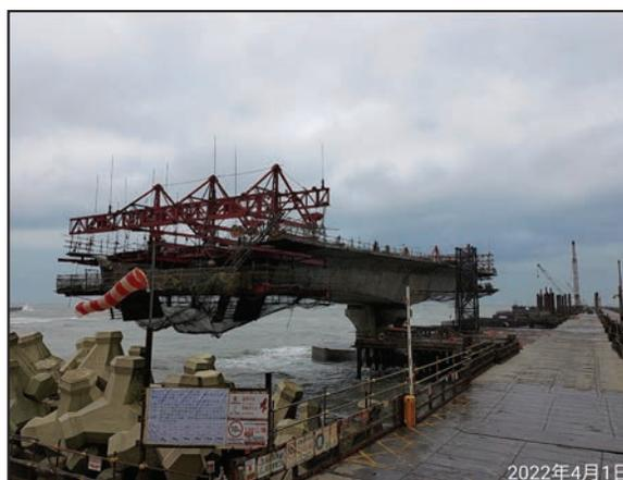
圖 20 本案懸臂工法施工照片
