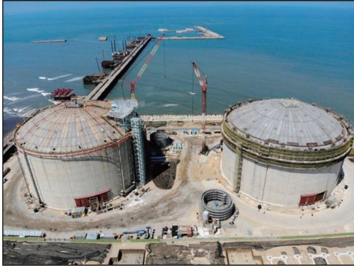
圖 7 第二座儲槽 (右邊) 屋頂吹浮升頂工程
