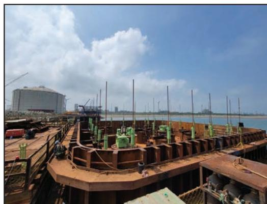
圖 18 本工程樁帽圍堰施工照片
