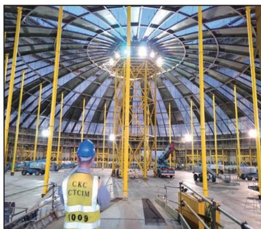
圖 6 儲槽內槽屋頂模組結構最大化安裝中
