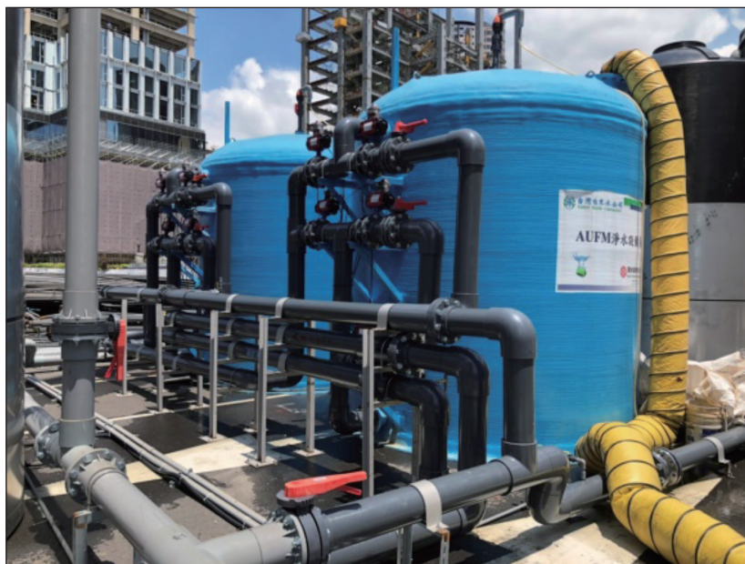
圖7 建築工地地下水利用情形
