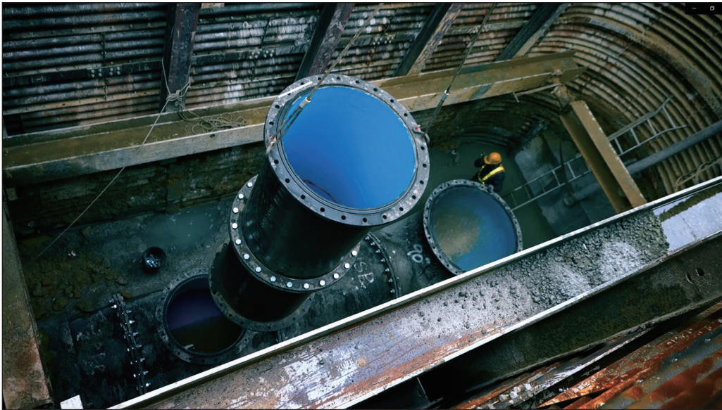
圖3 桃竹幹管施工情形
