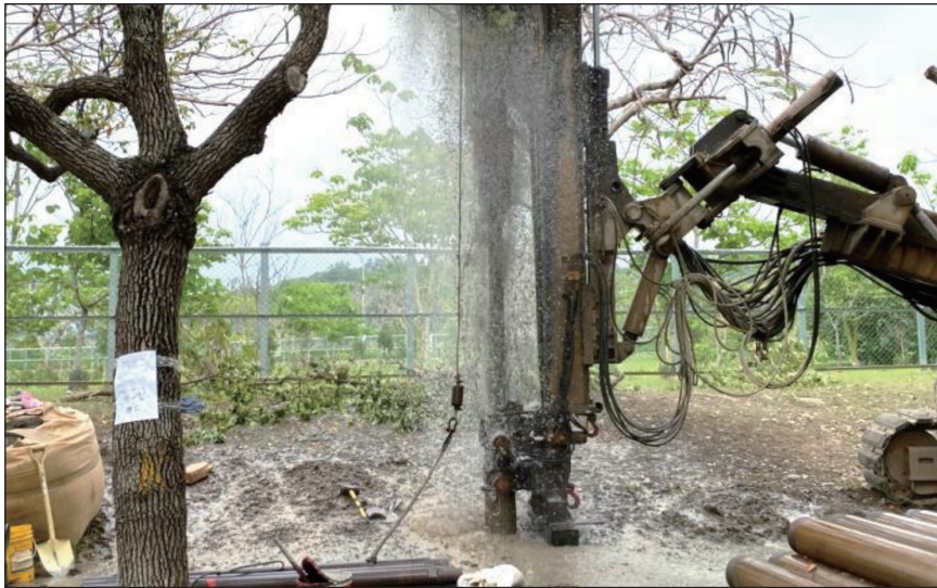
圖 4 抗旱水井施工情形
