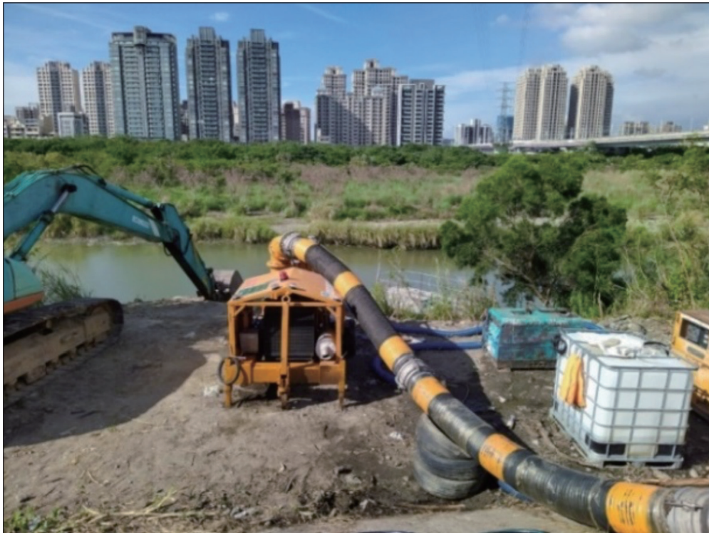
圖 16 隆恩壩下游緊急抽水情形
