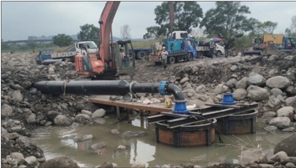
圖 15 油羅溪緊急抽水施工照片
