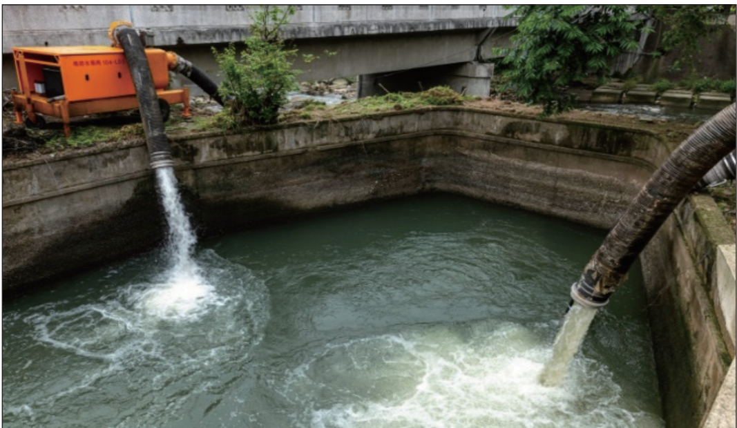
圖 6 支援桃3灌區移動式抽水機抽水情形
