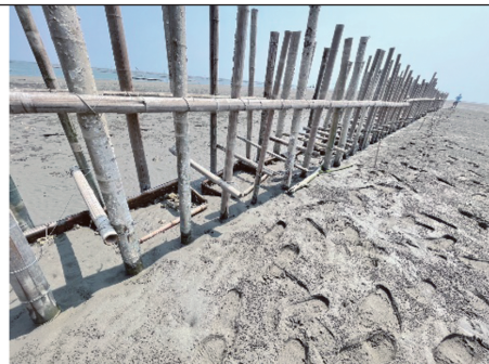
10月6日現勘、測量淤沙高度 竹籠下沉、下半部沒入沙中
