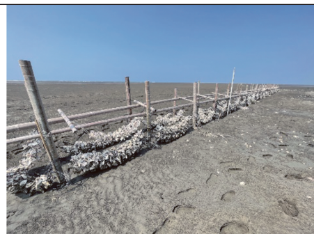
10月6日現勘、測量淤沙高度 最下層蚵殼已沒入沙中
