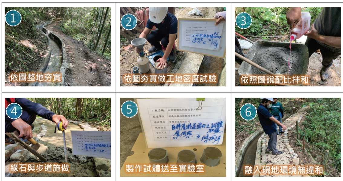
圖 6 自拌清淤道施工過程
