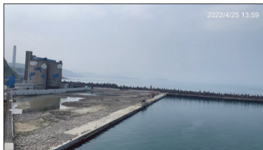
(b) 造地工程完工
