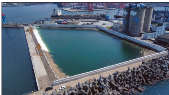
(a) 圍堤工程完工
