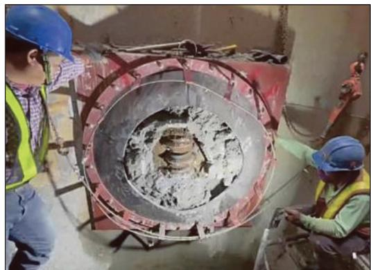
圖 14 破鏡到達施工圖
