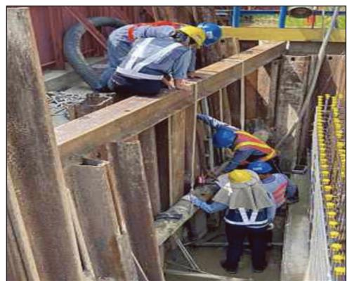
圖 11 油氣管吊掛施工圖
