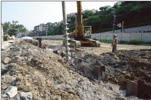
圖 17 舊橋基礎預鑽引孔植入鋼板樁現況
