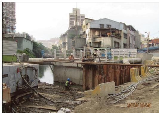
圖 20 海砂屋旁採靜壓工法施作臨時擋土
