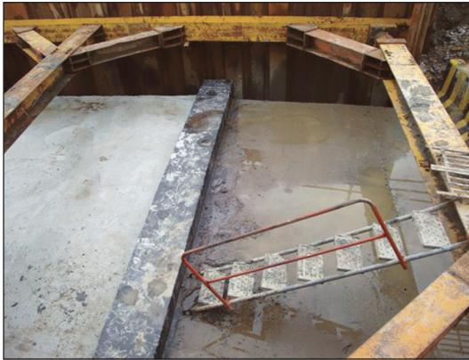
圖 24 管道段落間設計壓梁
