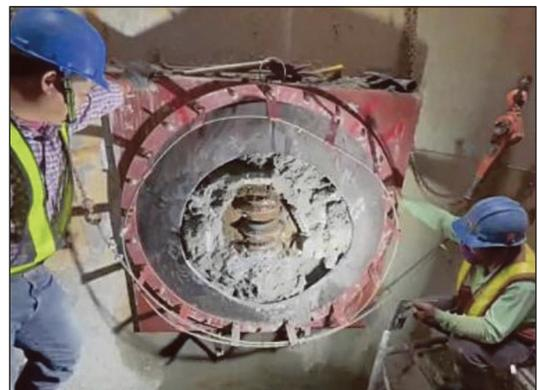
圖 14 破鏡到達施工圖
