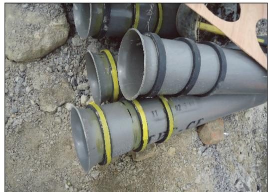
圖 23 預埋過牆管施工示意圖
