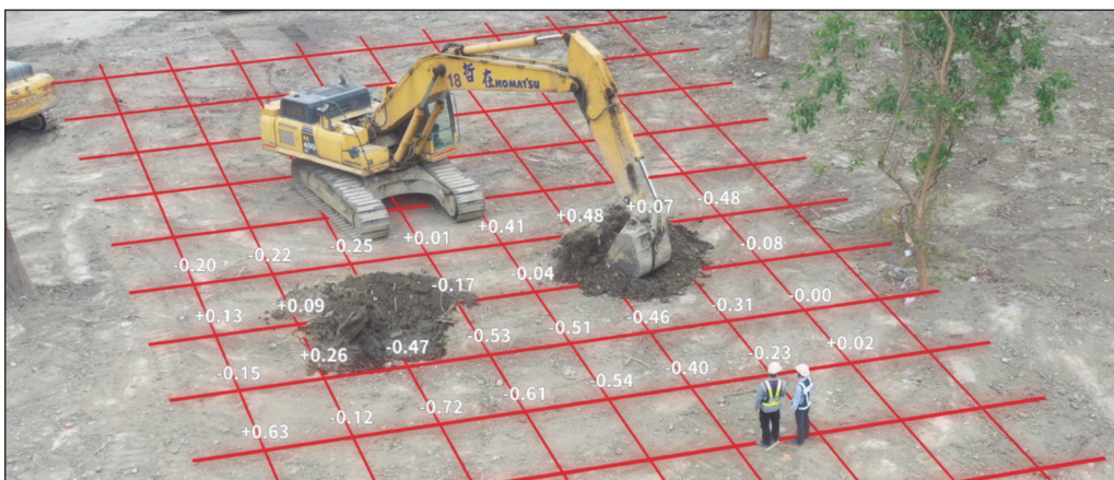
圖 13 衛星定位進行土方整地
