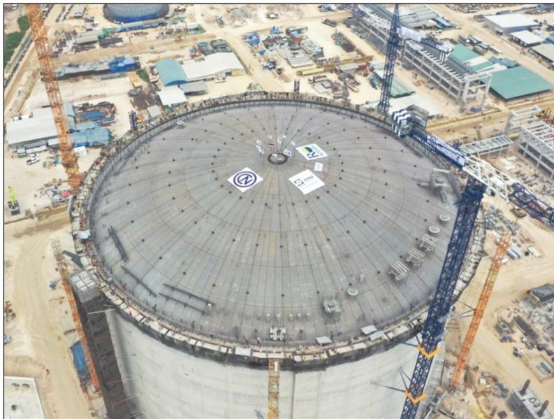
圖 5 儲槽升頂施工照片
