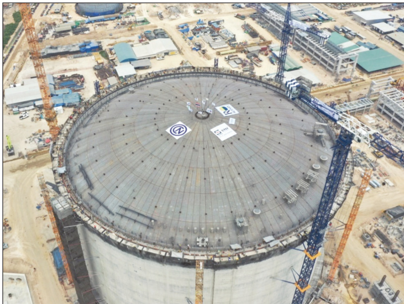
圖 5 儲槽升頂施工照片
