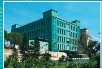
生技廠工程 Biopharmaceutical Plant
