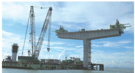
▲ 金門大橋施工情形
