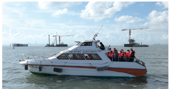
▲ 參訪金門大橋工程
