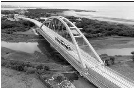
圖 18 遠眺臺灣海峽之藍海橋
