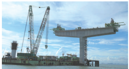
▲ 金門大橋施工情形
