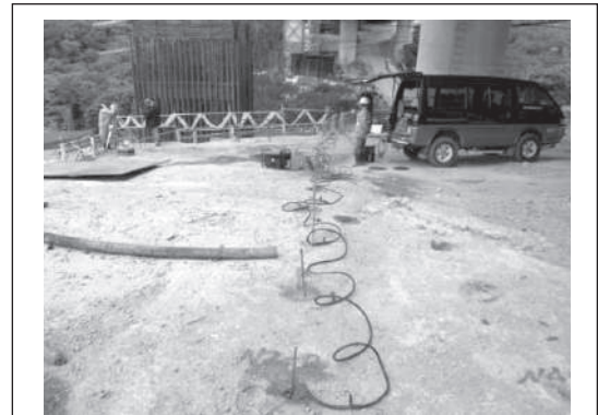
電阻試驗作業情形
