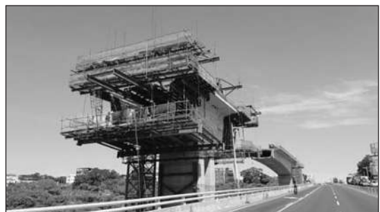
圖 11 地盤改良後順利施工之 p17 墩柱
