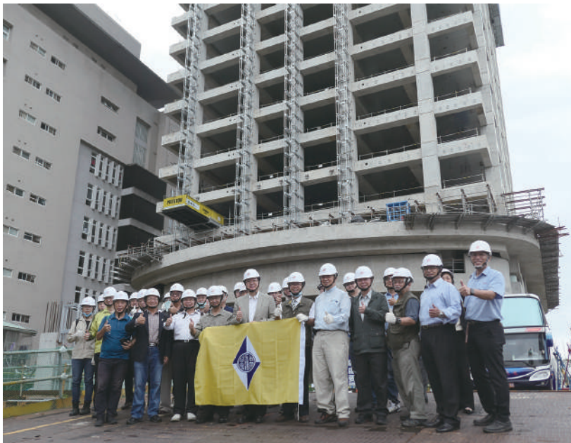
▲ 參訪人員於T-PARK專二B區集合住宅大樓工地前合影
