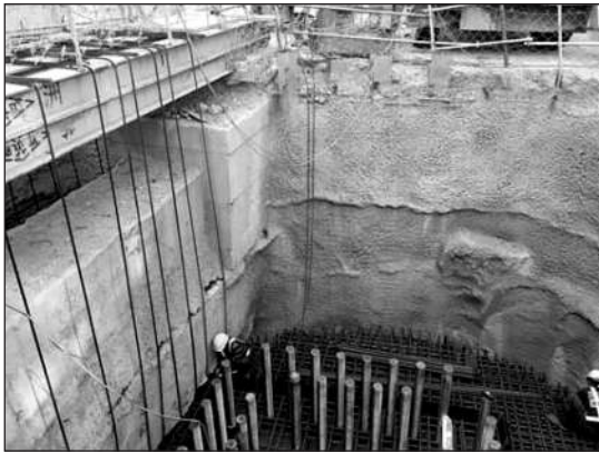
圖5 台電 161 kV 高壓電纜吊掛示意圖
