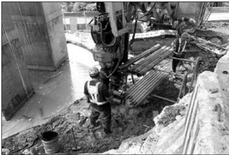
圖 8 地盤改良雙環塞灌漿施工
