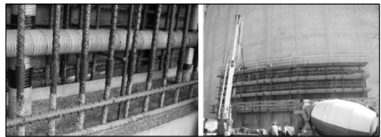
圖 10 臨時開口封閉
