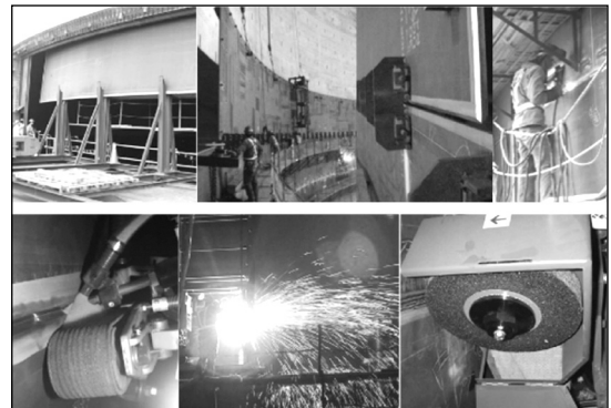
圖 29 內槽殼板組立及銲接
