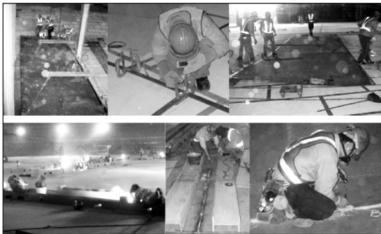
圖 27 內槽底板組立、銲接及檢驗
