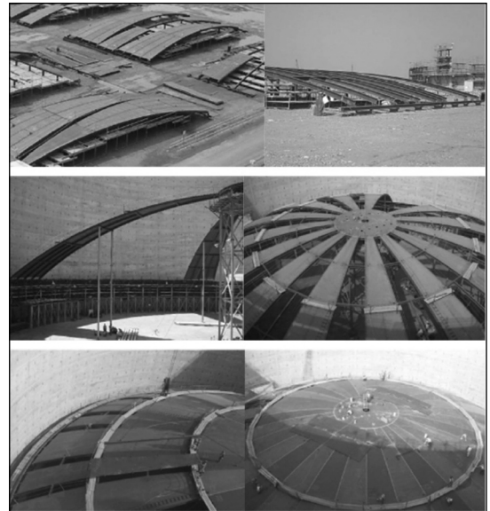
圖 21 內槽槽頂預製、安裝及銲接
