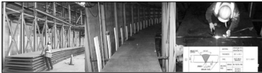
圖 24 環狀底板安裝及銲接
