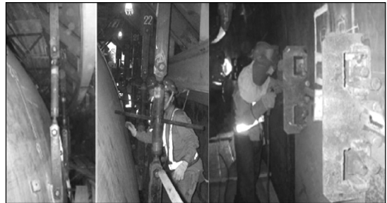
圖 32 內槽頂降下、組立及銲接
