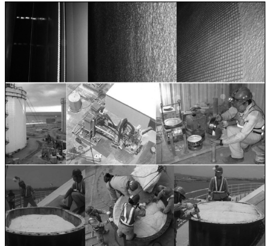
圖 35 內外槽夾層間保冷施工
