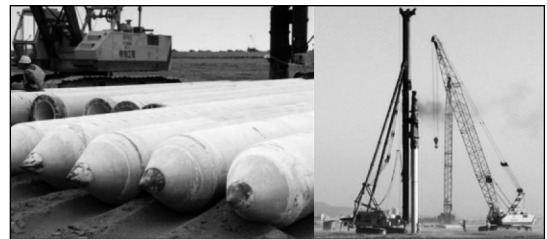
圖 6 基樁打設情形
