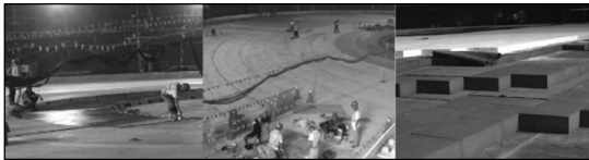
圖 26 底板中心部位保冷施工
