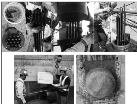
圖 12 垂直及水平預力與封填作業
