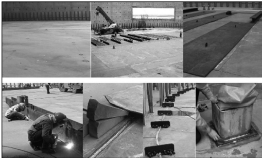
圖 17 底部襯板鋪設、銲接及檢驗
