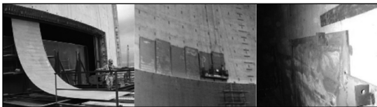
圖 31 外槽襯板安裝及銲接
