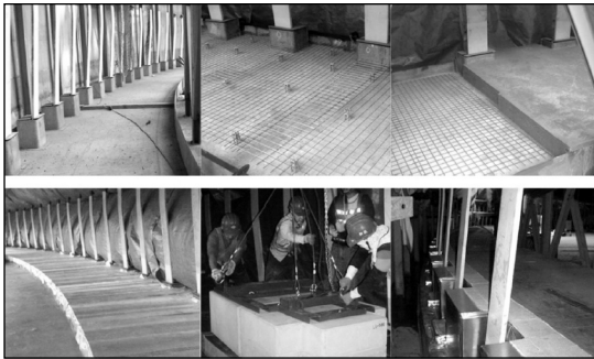
圖 23 底板環狀部保冷施工概況
