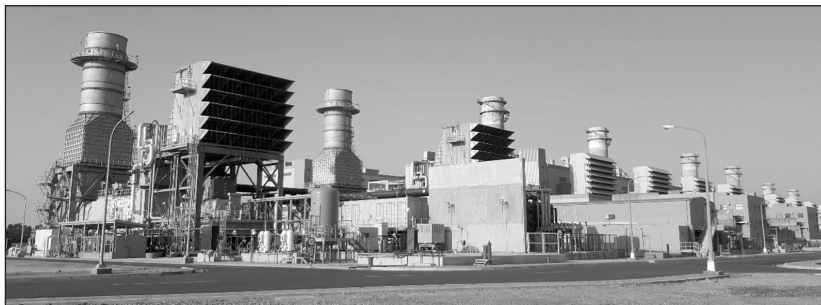
圖 4 大潭電廠 1~7 號機組
