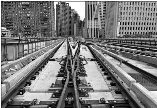
圖 10 可動式岔心 (Swing Nose Crossing)
