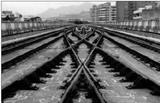
圖 9 固定式岔心 (Fixed Nose Crossing)
