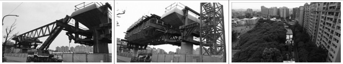
圖 30 船型桁架場撐工法施工實況
