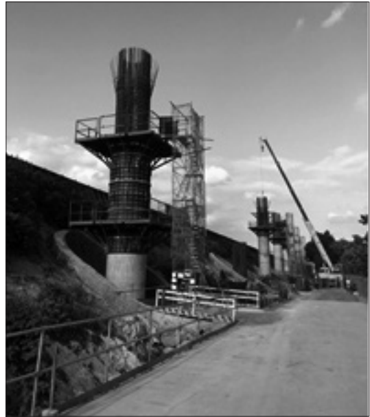
圖 24 墩柱鋼筋綁紮輕量碟型工作平台
