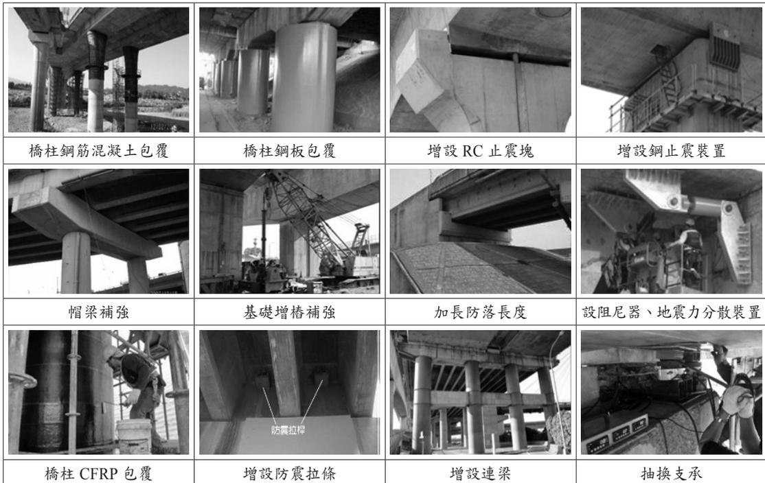
圖 11 橋梁耐震補強工法施作情形
