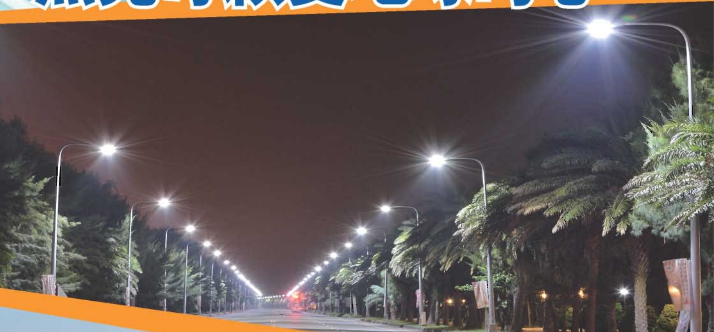
LED照明系統
