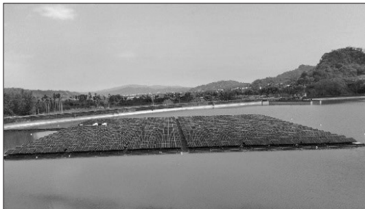
圖 2 馬鞍後池浮動式太陽光電系統
