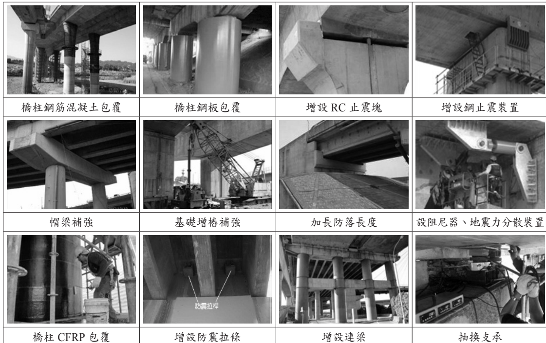
圖 11 橋梁耐震補強工法施作情形
