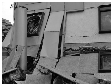
圖 9 統帥飯店補強構件破壞樣態 (來源：本文整理)
