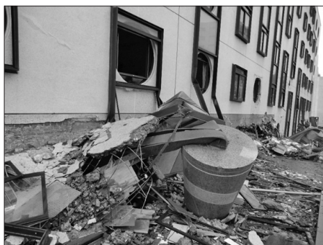
圖 9 統帥飯店補強構件破壞樣態 (來源：本文整理)
