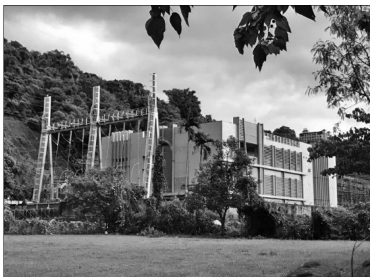
圖 5 明潭發電廠鉅工分廠
